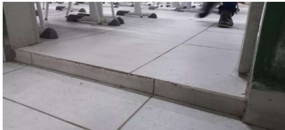
Foto 35. Batente na entrada da sala de aula
