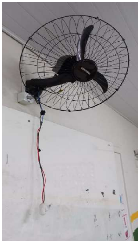
Foto 16. Instalação de ventilador
