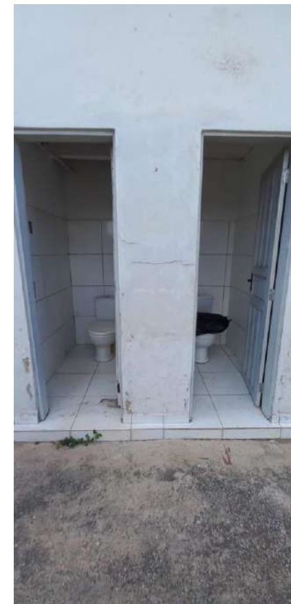
Foto 28. Portas dos banheiros sem acessibilidade (estreitas e com batente)
