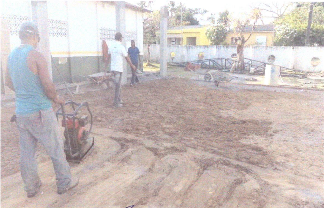
02-vista dos serviços de aterro e compactação na escola Pedro Oliveira.
