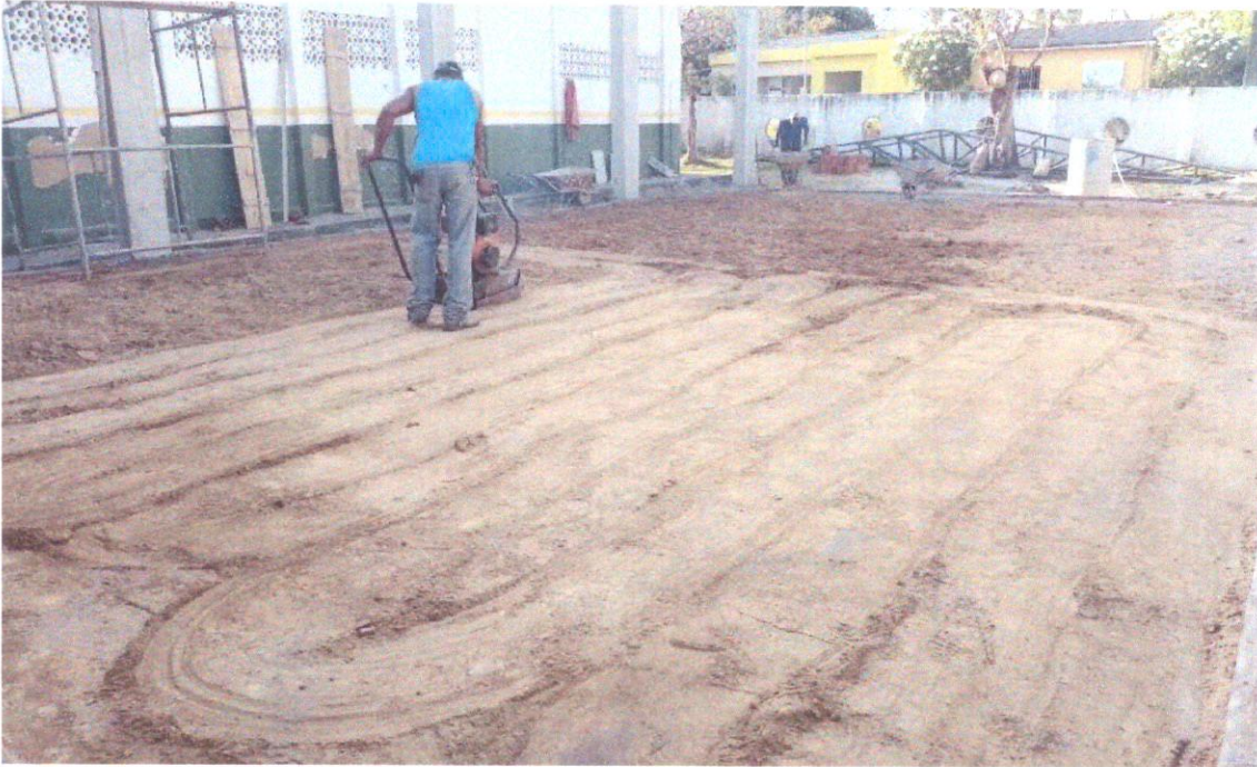
01-vista dos serviços de aterro e compactação na escola Pedro Oliveira.
